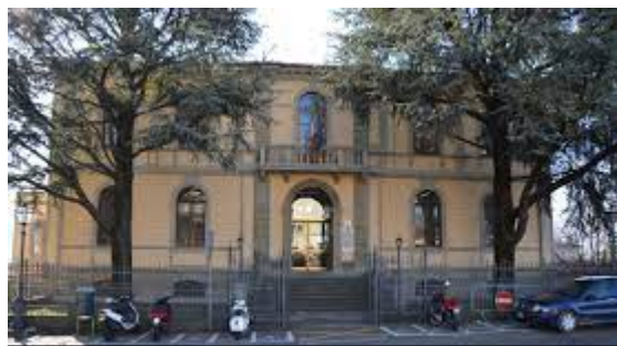
I.S.I.S. "E. FERMI" dal 1910
